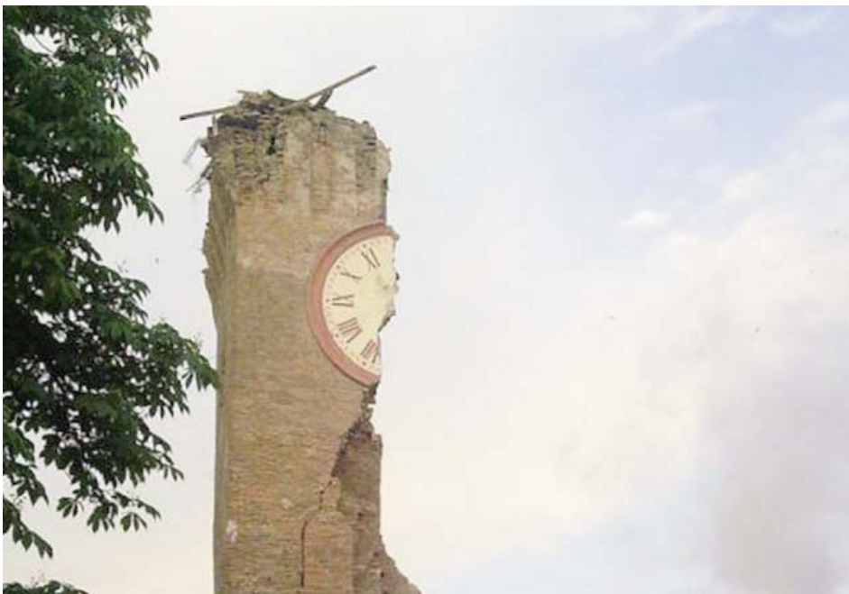
L'orologio del campanile di Sant'Agostino dopo il terremoto
